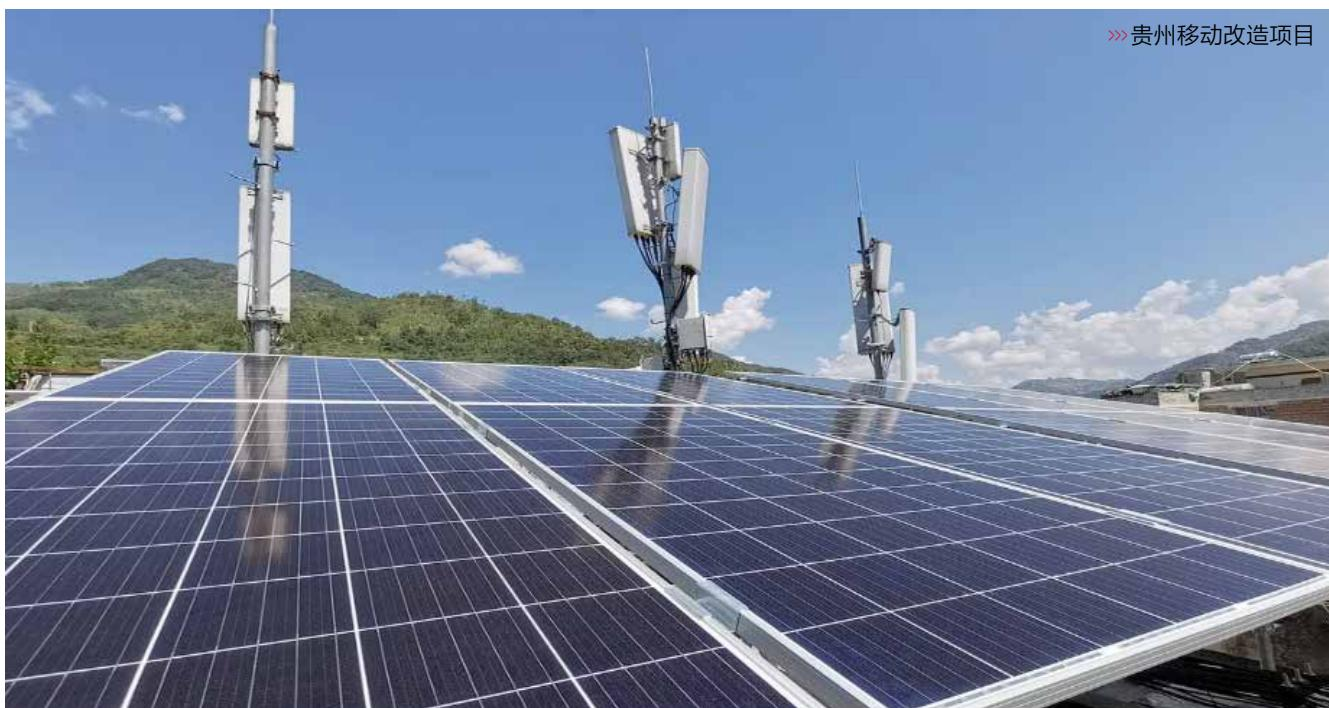
位受遮挡或问题组件，实现精准上站、高效运维。相比之下，若使用传统光伏发电方案，据测算每年会存在40%的无效上站，运维低效、成本高。同时，iPV智能光伏板集成软件锁，通信断开则切断输出，光伏板失去回收利用价值，可有效防止光伏板遗失的风险。
