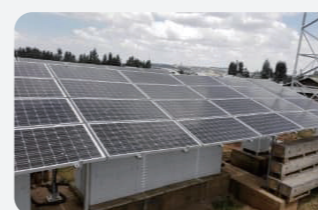
站点 | 机房 | 数据中心
