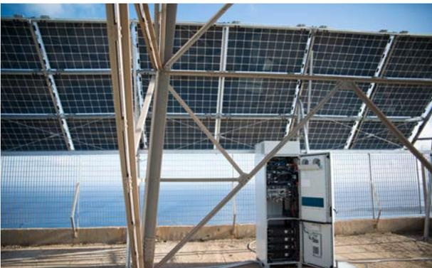
图 6：站点叠光，节电 14500kWh/ 年 @ 希腊
