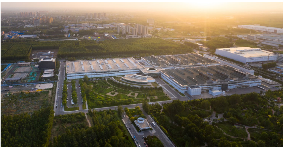
中国河北华为廊坊云数据中心
