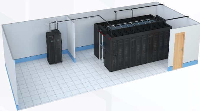
UPS外置精密配电柜场景
